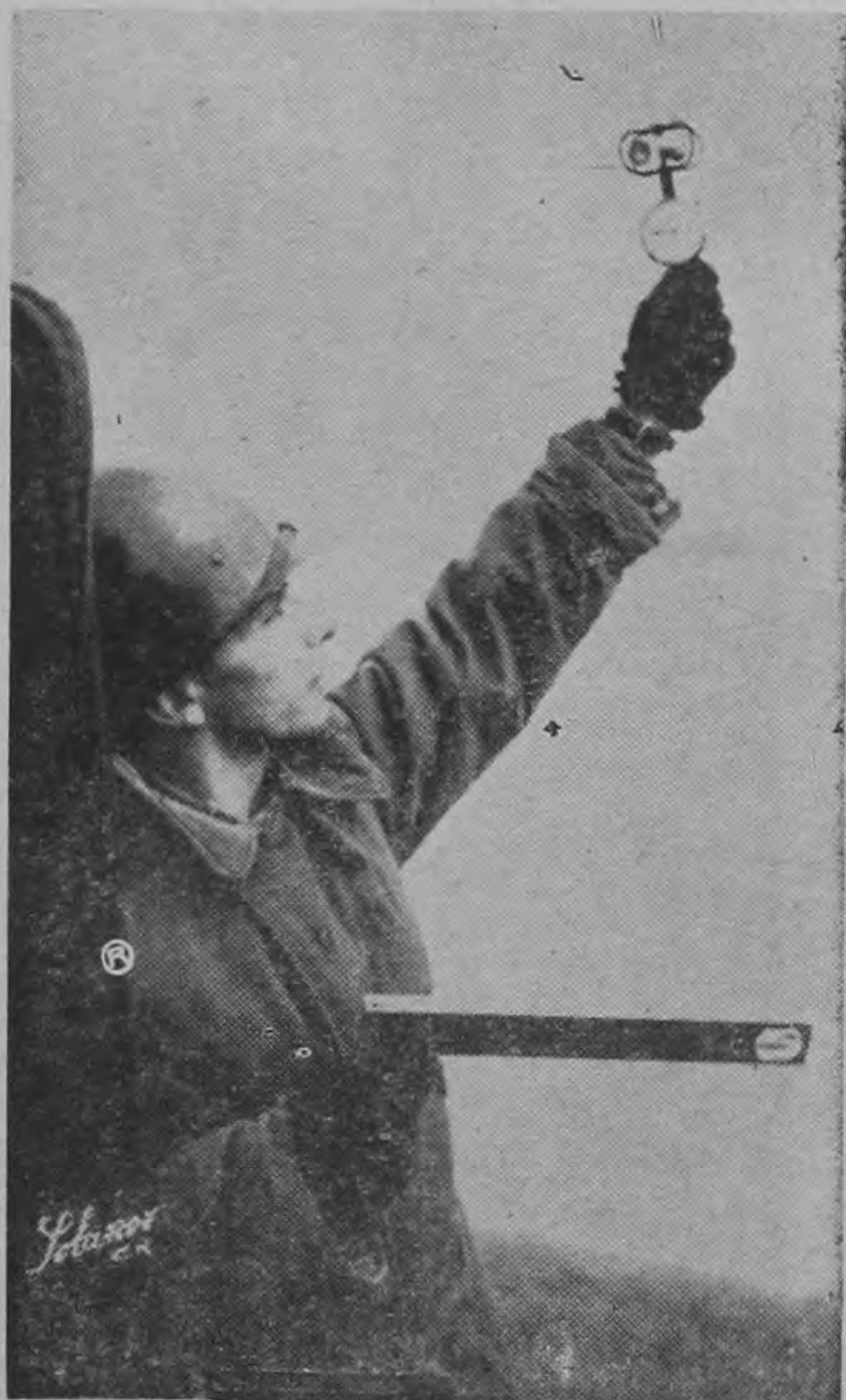
Uno de los Guardias Civiles de servicio junto al Irazú toma la velocidad del viento así como la humedad. Luego por radio se comunicará con la Oficina Meteorológica en San José...
